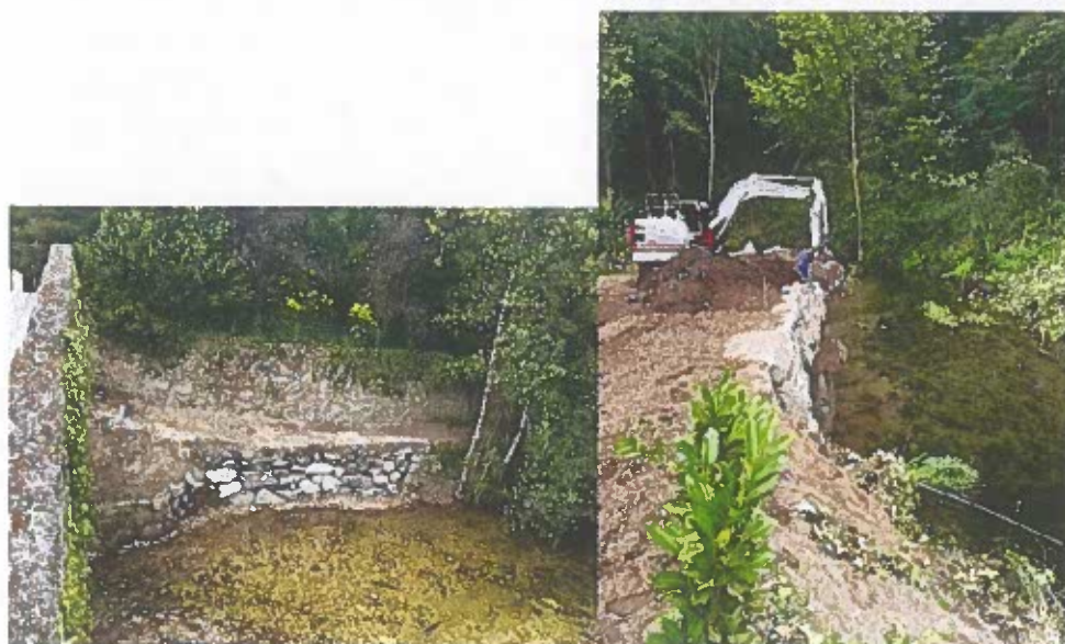
Figura 6– Margem do Rio Ferro – Ponte Travassós
