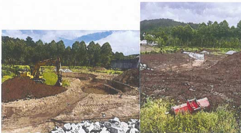
Figura 4 – Construção da Zona de Inundação preferencial
