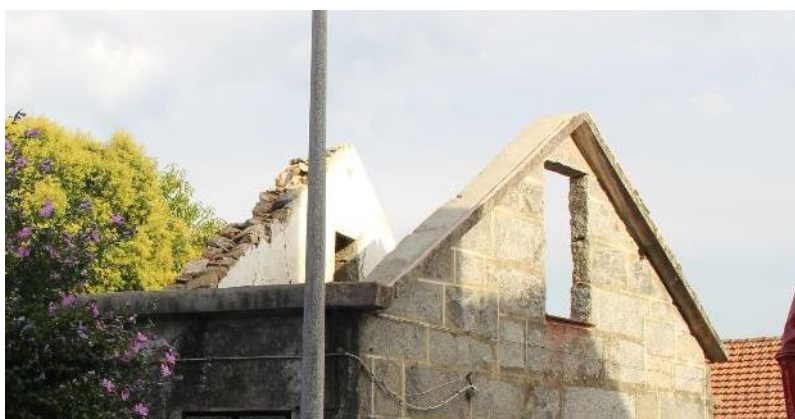
Figura 34. Cobertura colapsada
