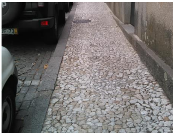
Figura 62. Passeio em razoável estado de conservação
