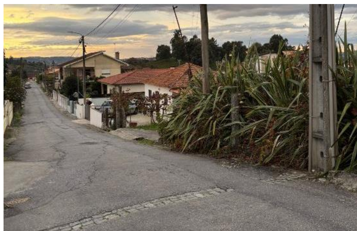
Figura 66. Situações onde ocorre ausência de passeio
