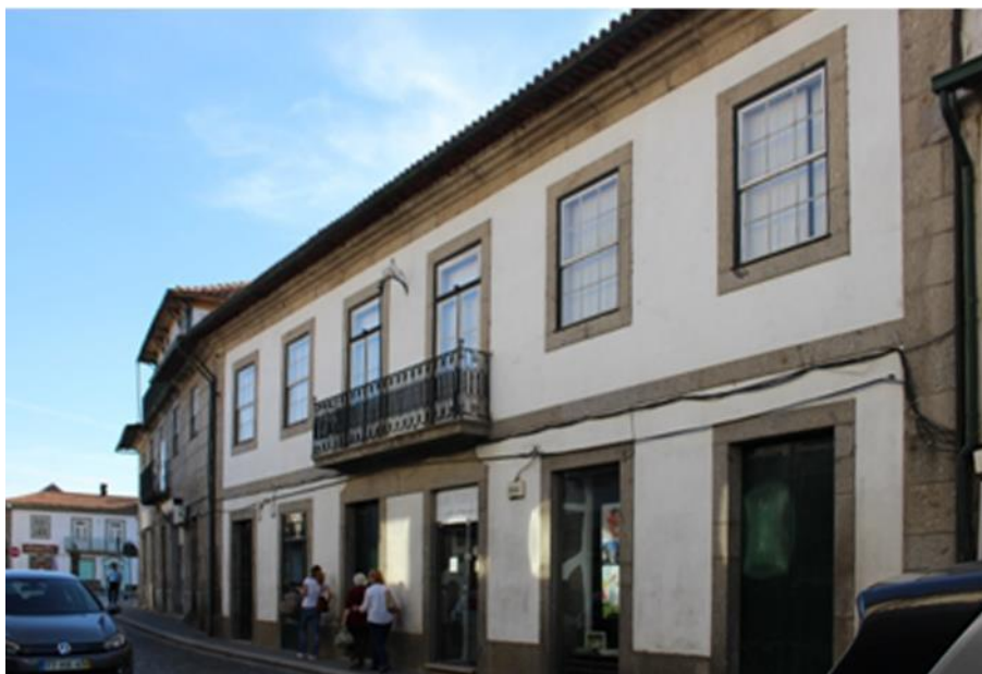
Figura 32. Edifício na EN 101 (3)
