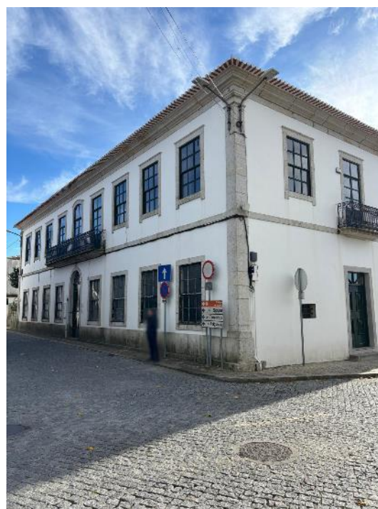
Figura 67. Edifício da Junta de Freguesia
