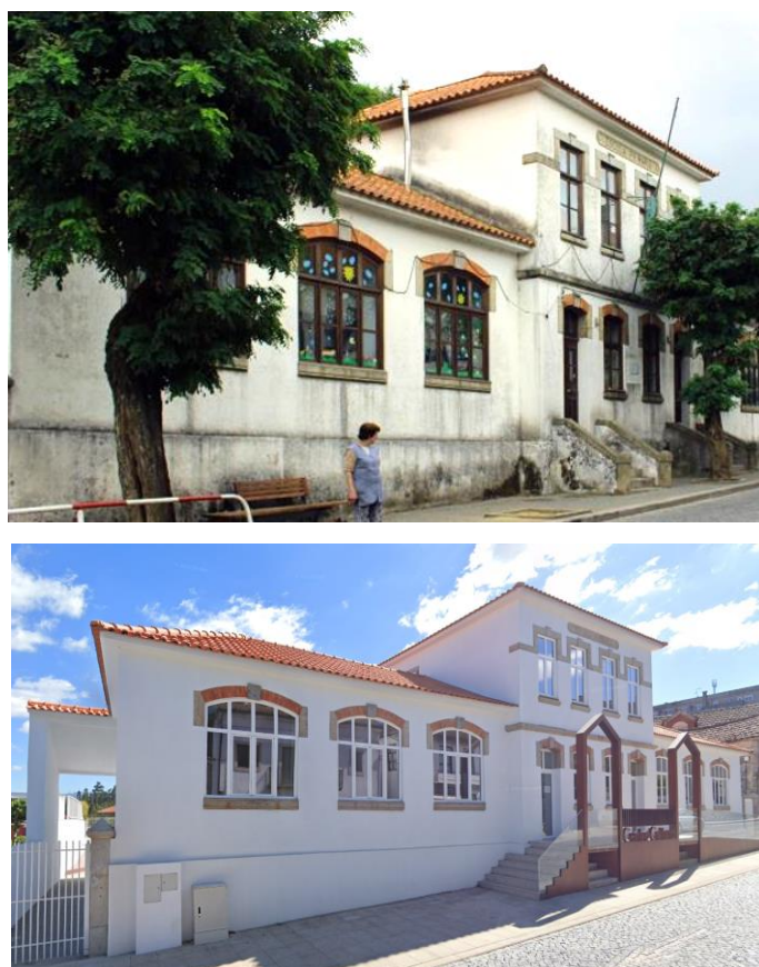
Figura 48. Escola Primária de Adães Bermudes na EN101, antes e depois das obras de reabilitação (19)
