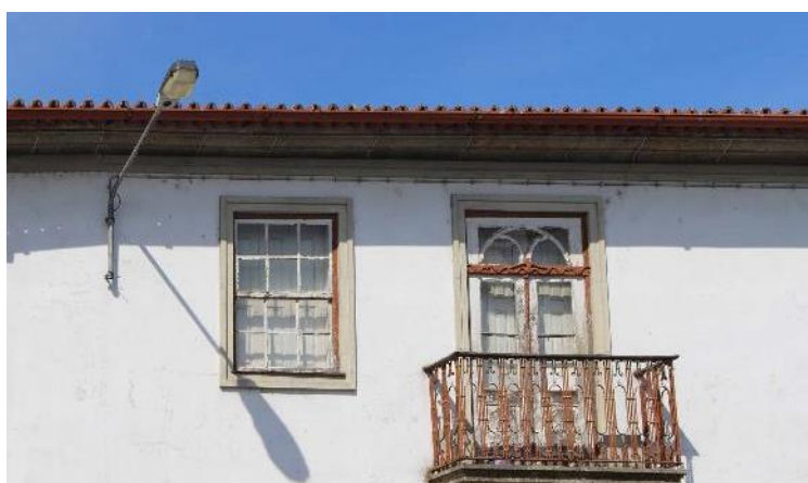
Figura 47. Caixilharia degradada
