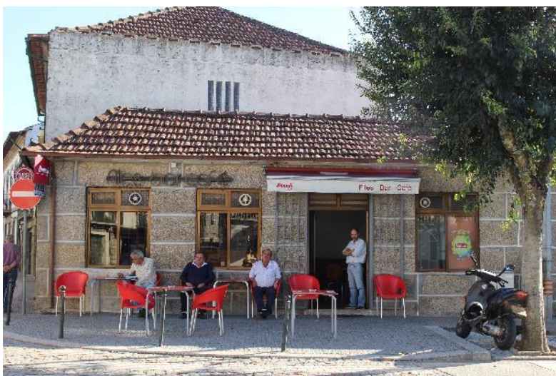
Figura 71. Pilaretes na Rua Aníbal Ferreira Basto
