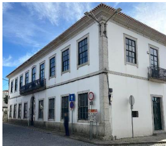
4 - Edifício da Junta de Freguesia
