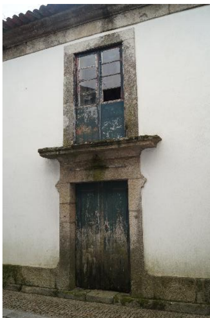
Figura 37. Caixilharia degradada
