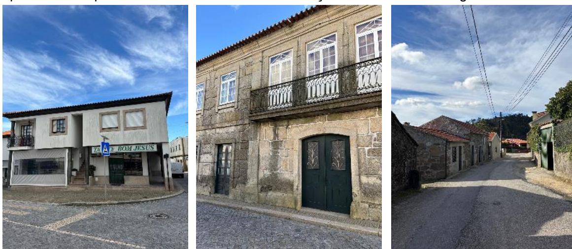
Figura 44. A-Passeio adequado à circulação; B-Passeio sem dimensões adequada à circulação; C- Via sem passeio para a circulação pedonal
