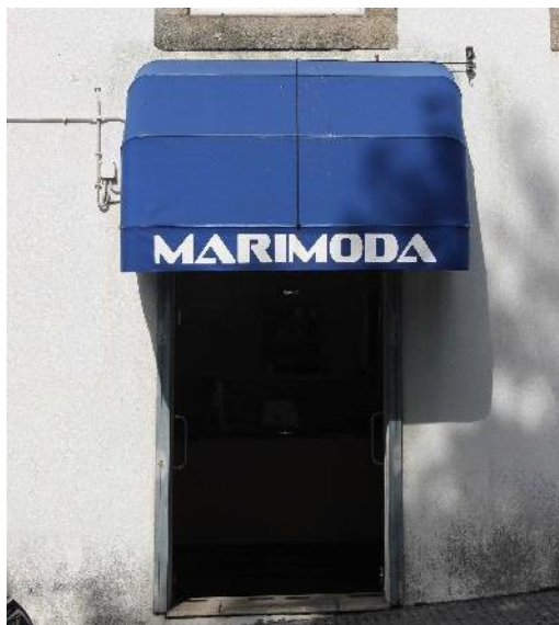
Figura 46. Toldo de sombreamento em piso comercial
