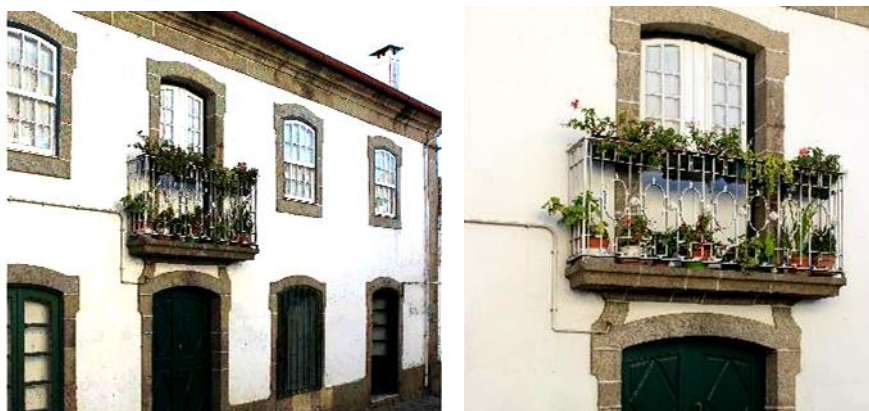
Figura 37. Edifício na Rua Dr. Leonardo Coimbra (8)
