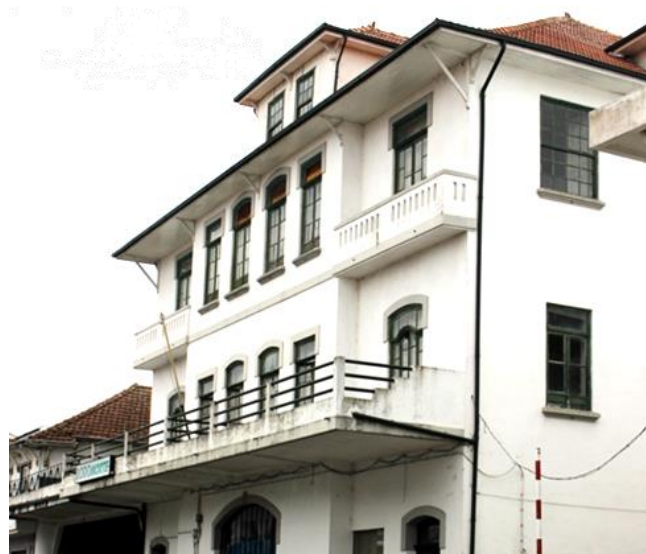
Figura 36. Edifício da Rodoviária na Rua 25 de Abril (7)
