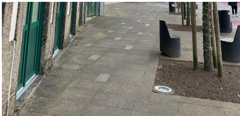
Figura 68. Pavimento em bom estado de conservação, Praça Dr. José Joaquim Coimbra
