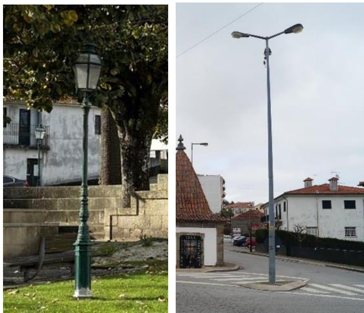
Figura 49. Exemplo de luminárias na vila de Barrosas
