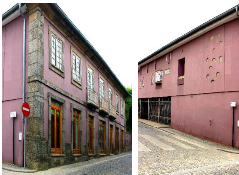
Figura 38. Edifício na Rua Dr. Leonardo Coimbra (9)
