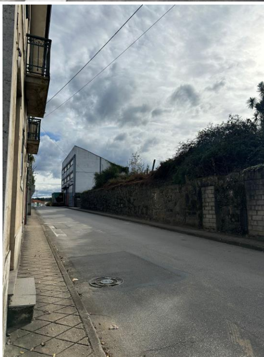
Figura 29. A - Exemplo de passeio ocupado por veículos mal estacionados; B - Exemplo de passeio subdimensionado
