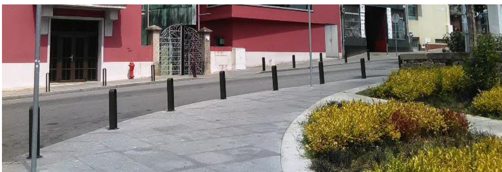
Figura 65. Passeio em bom estado de conservação
