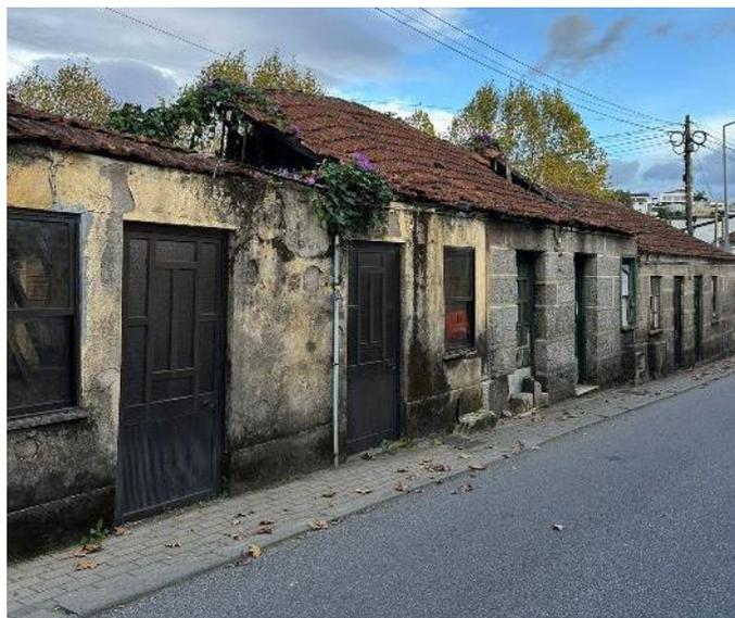
Figura 58. Edifício com deformações na cobertura
