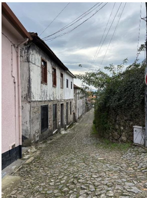
Figura 58. Ausência de passeio, Travessa da Póvoa
