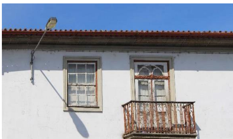
Figura 47. Caixilharia degradada
