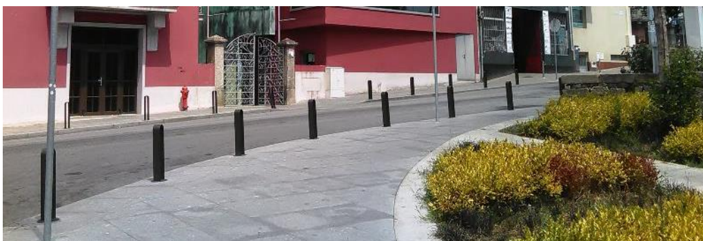
Figura 65. Passeio em bom estado de conservação
