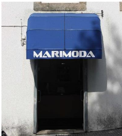
Figura 46. Toldo de sombreamento em piso comercial
