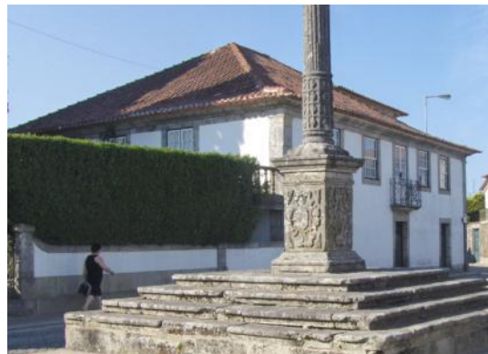
8 - Edifício no Largo do Cruzeiro
