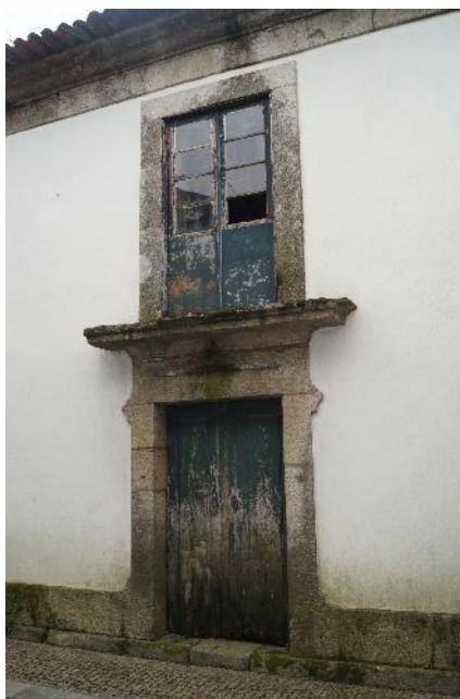
Figura 37. Caixilharia degradada
