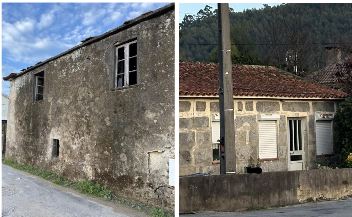
Figura 30. Caixilharias degradadas
