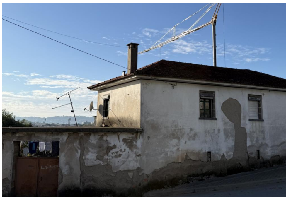
Figura 28. Desagregação do reboco
