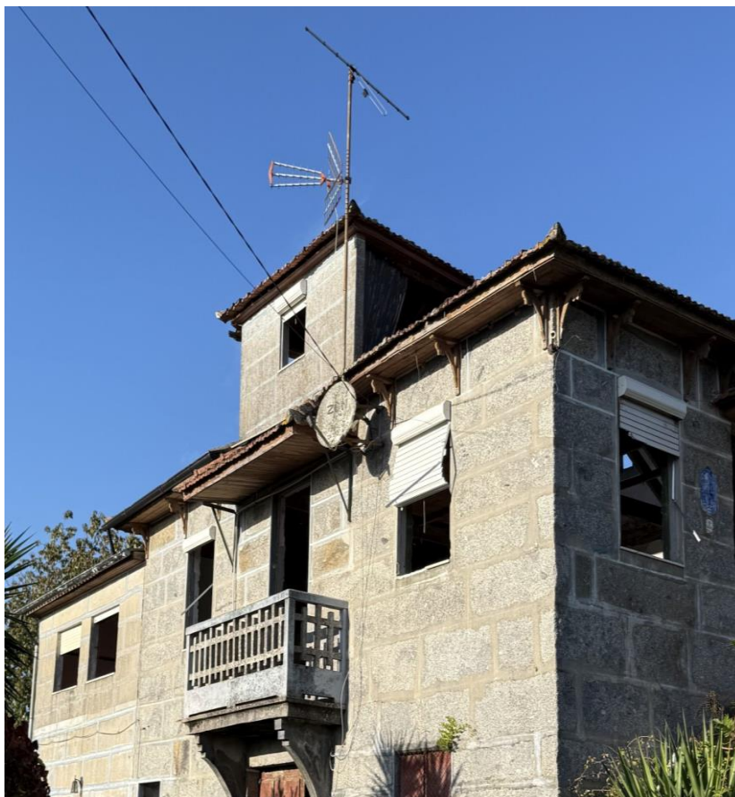
Figura 31. Edifício com ausência de caixilharia
