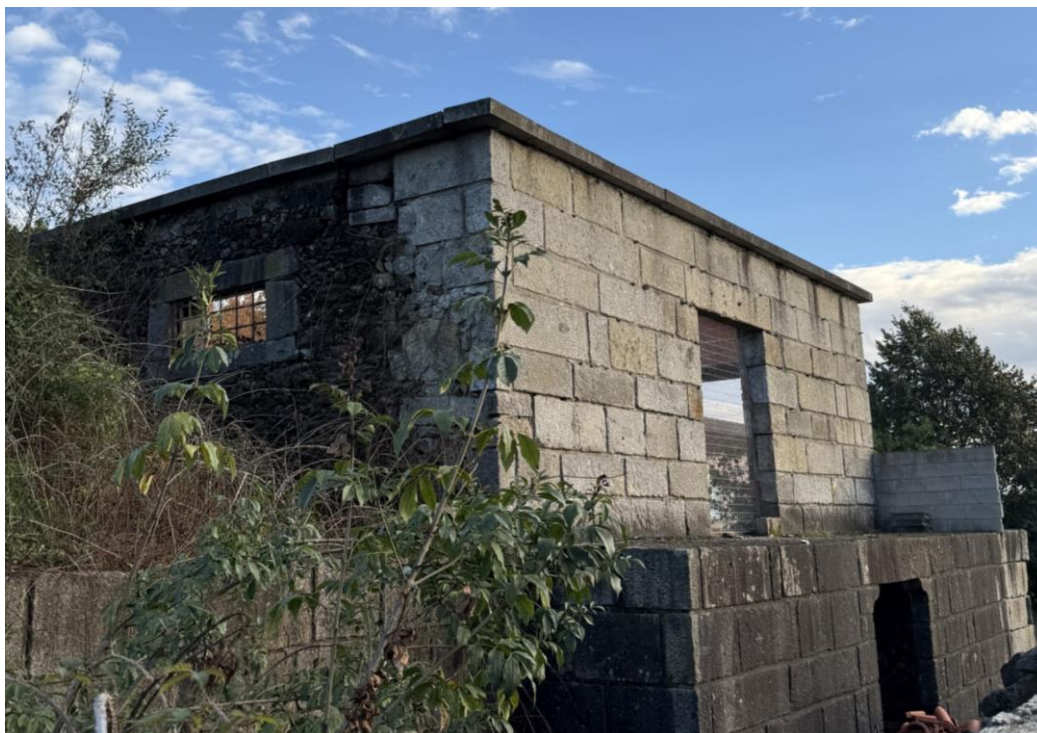
Figura 25. Cobertura colapsada
