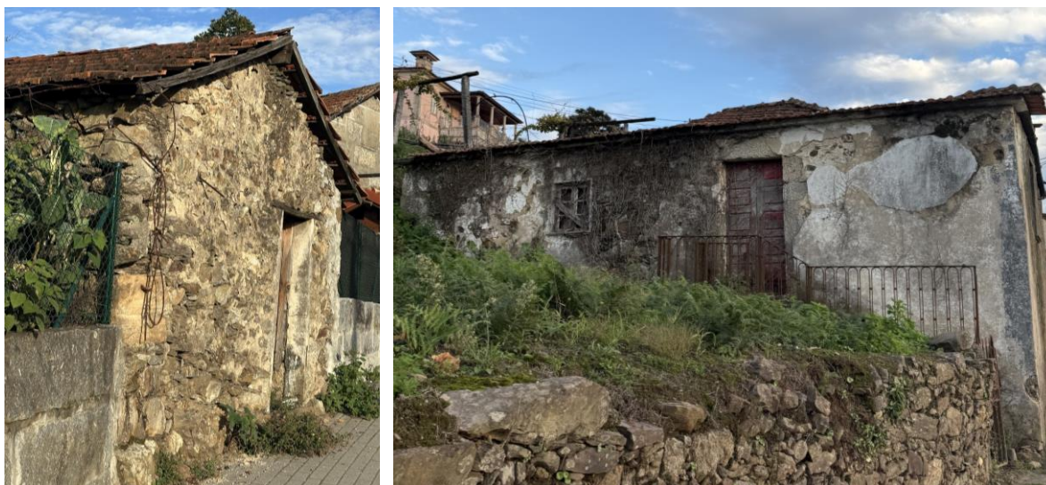
Figura 24. Coberturas deformadas
