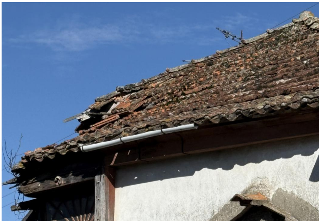
Figura 27. Coberturas colapsadas
