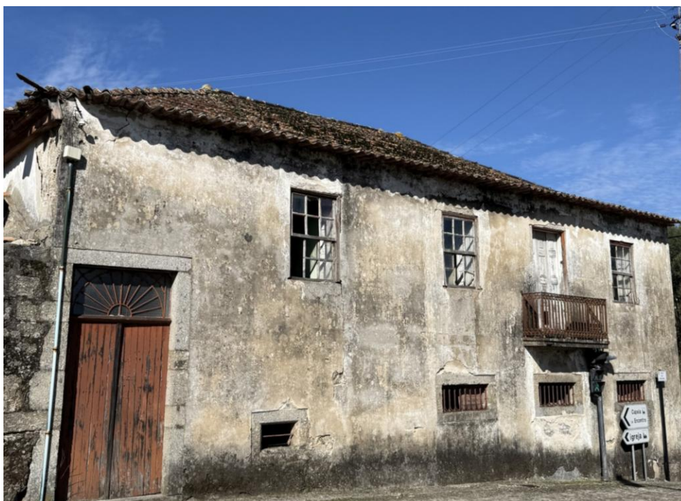
Figura 26. Cobertura deformada
