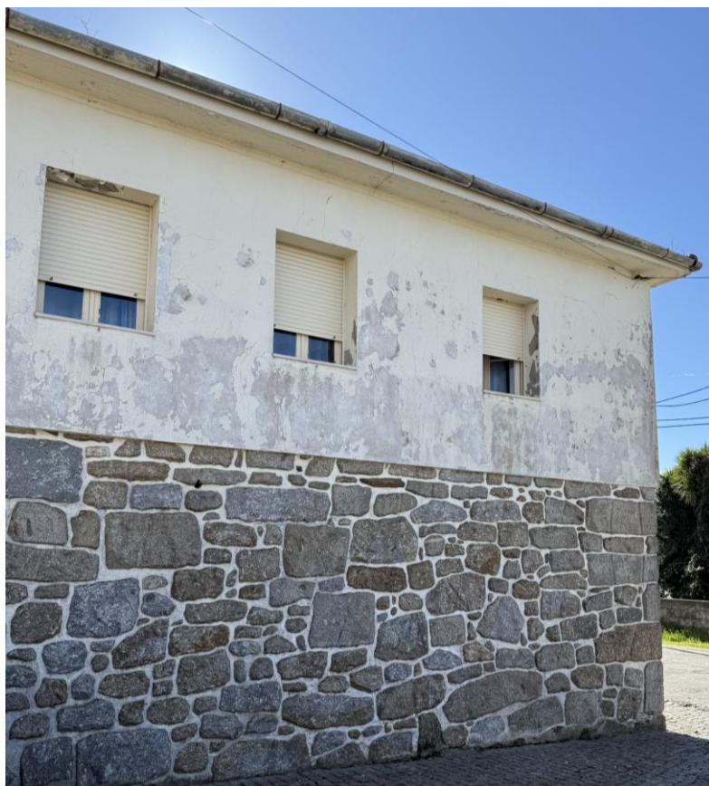
Figura 30. Desagregação do reboco
