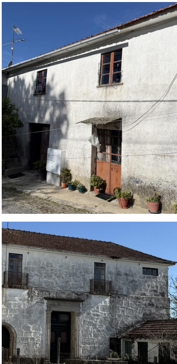
Figura 32. Caixilharias degradadas
