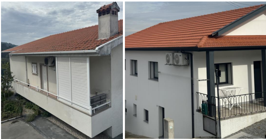
Figura 29. Presença de máquinas de AC
