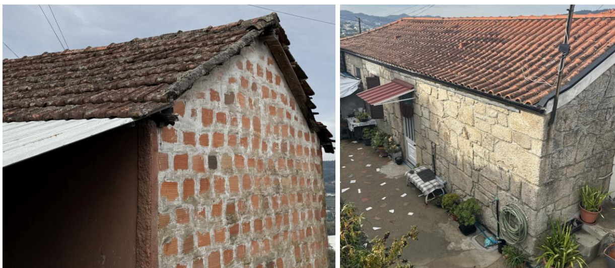
Figura 24. Coberturas deformadas
