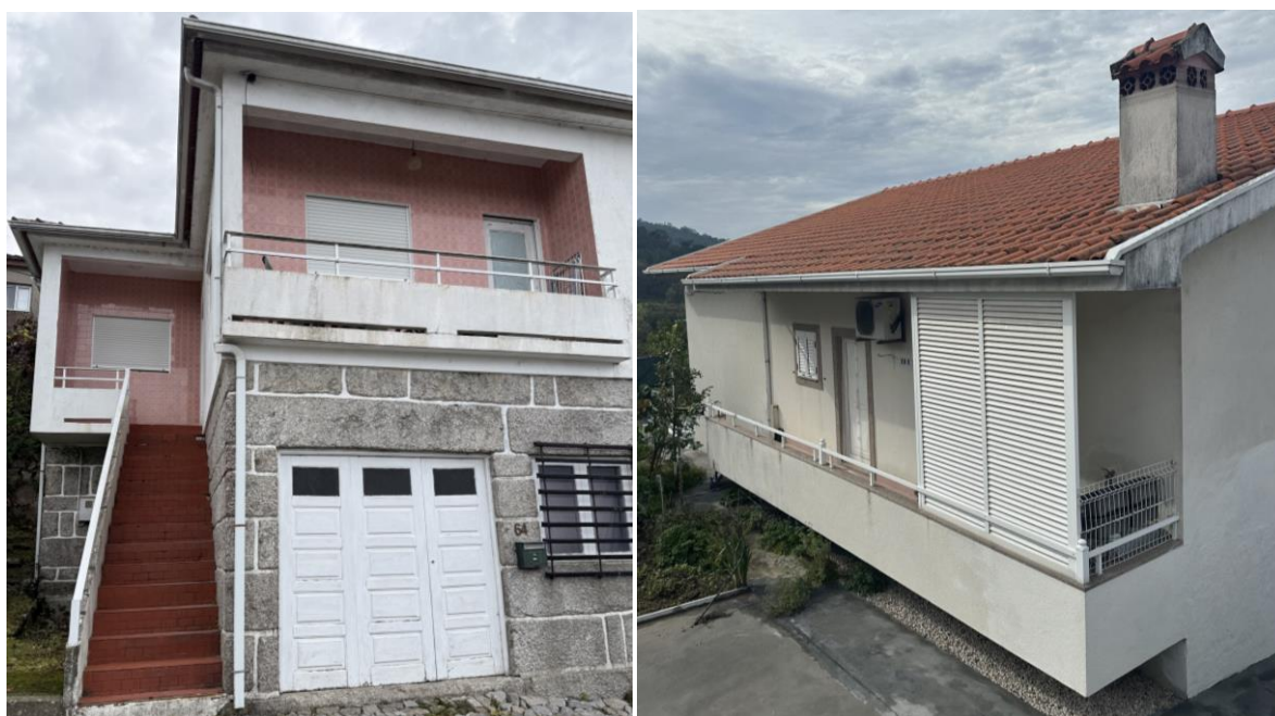
Figura 23. Cobertura com caleira
