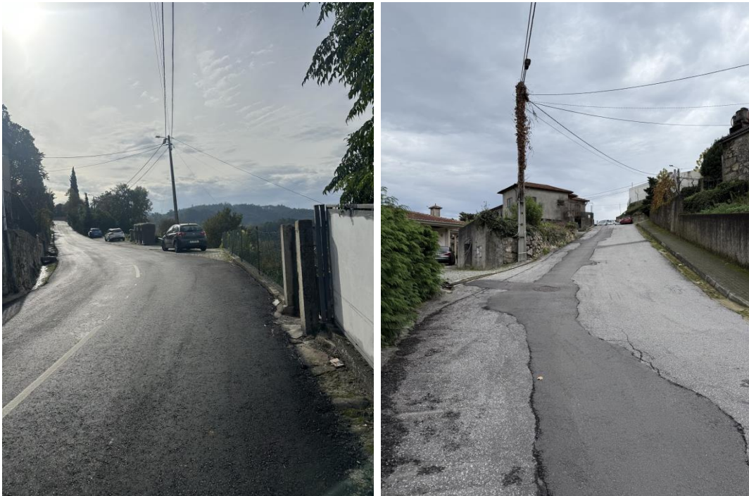
Figura 41. Exemplos da estrutura viária de Regilde
