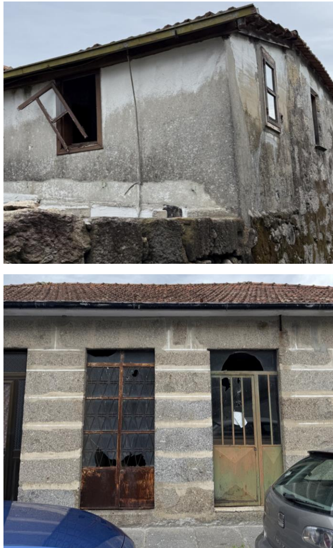
Figura 30. Caixilharias degradadas
