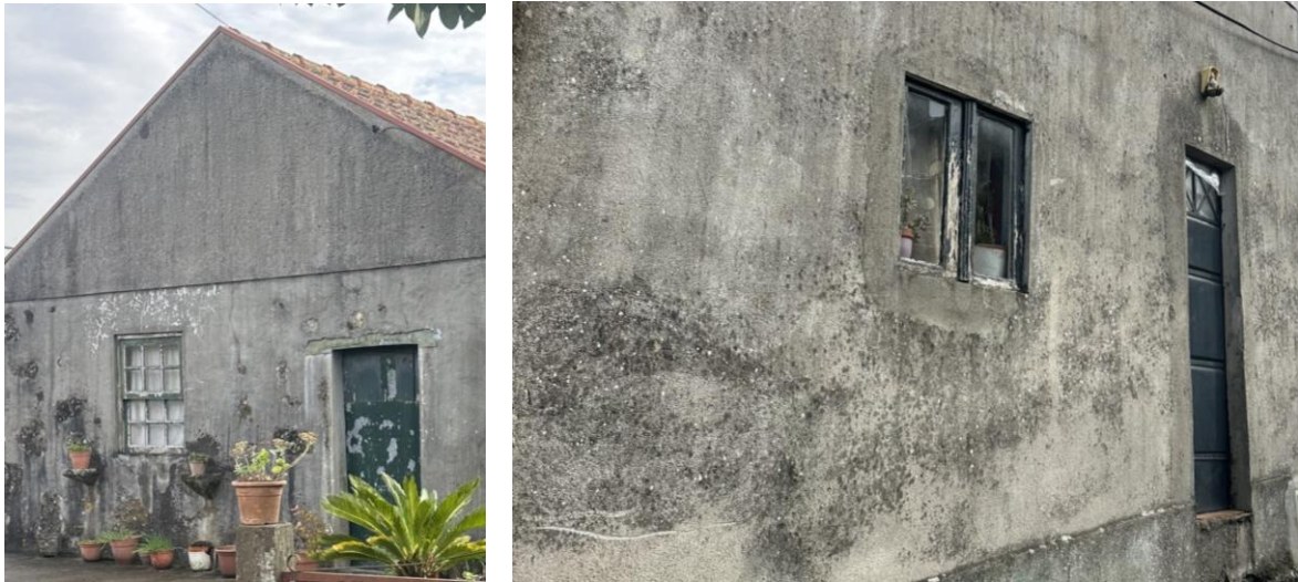
Figura 33. Caixilhariias degradadas
