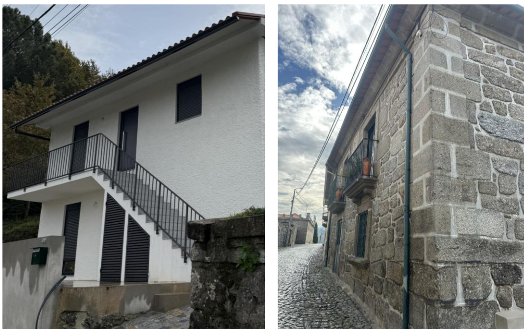
Figura 26. Cobertura com caleira
