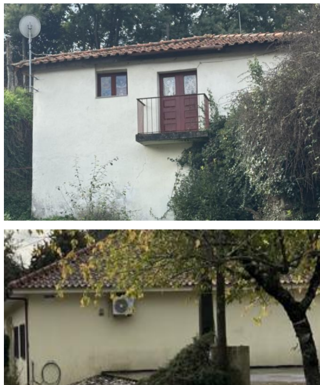
Figura 32. Presença de máquinas de AC e antenas de televisão
