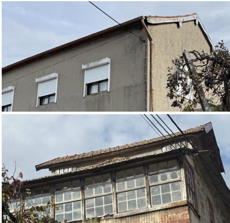
Figura 27. Cobertura deformada
