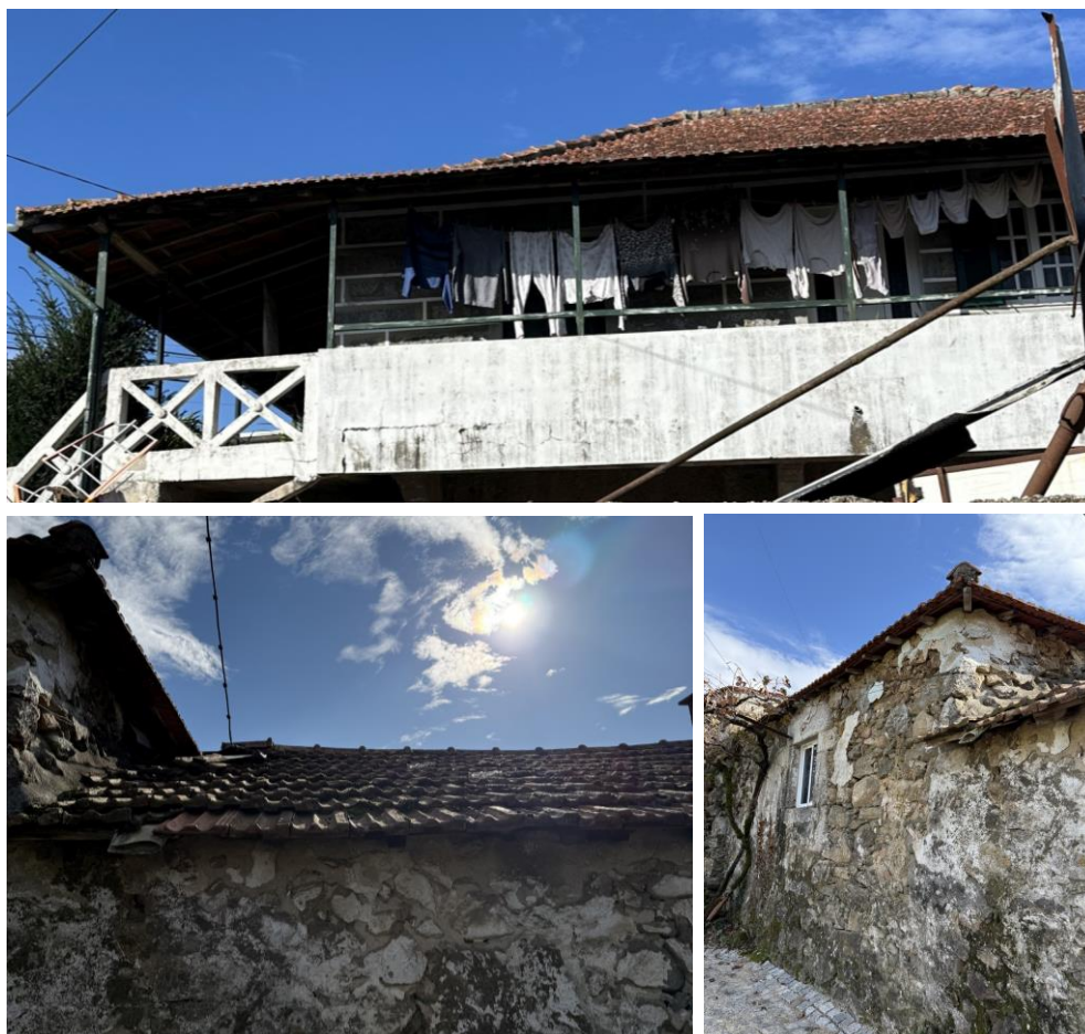
Figura 24. Coberturas deformadas
