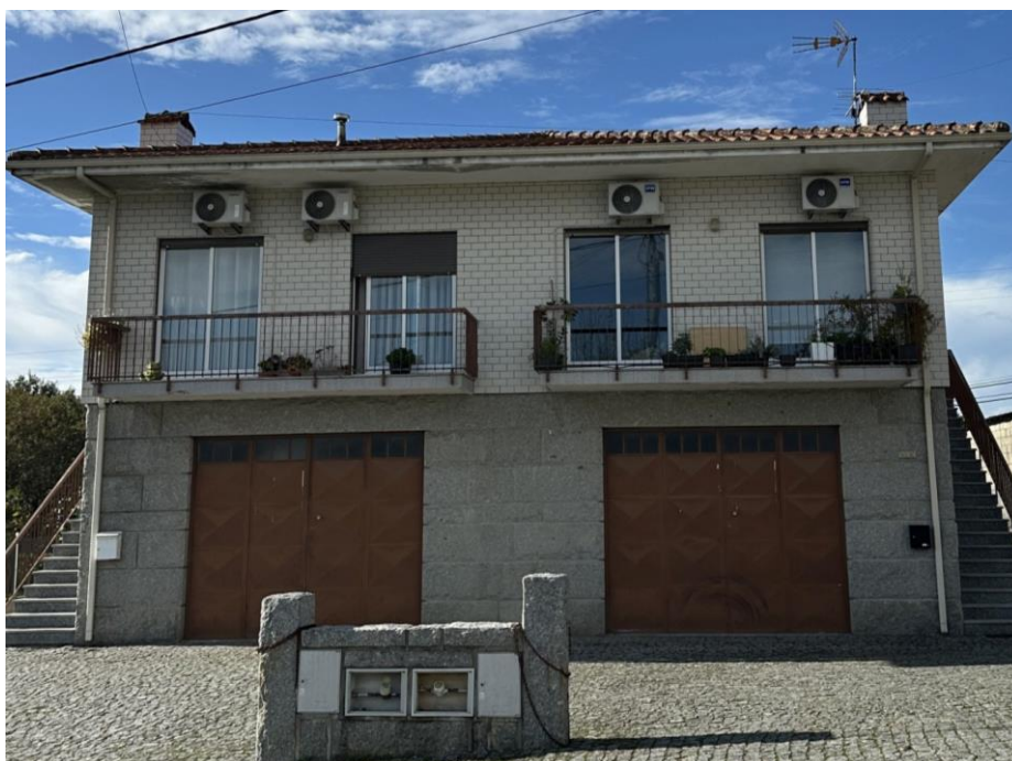
Figura 29. Presença de máquinas de AC
