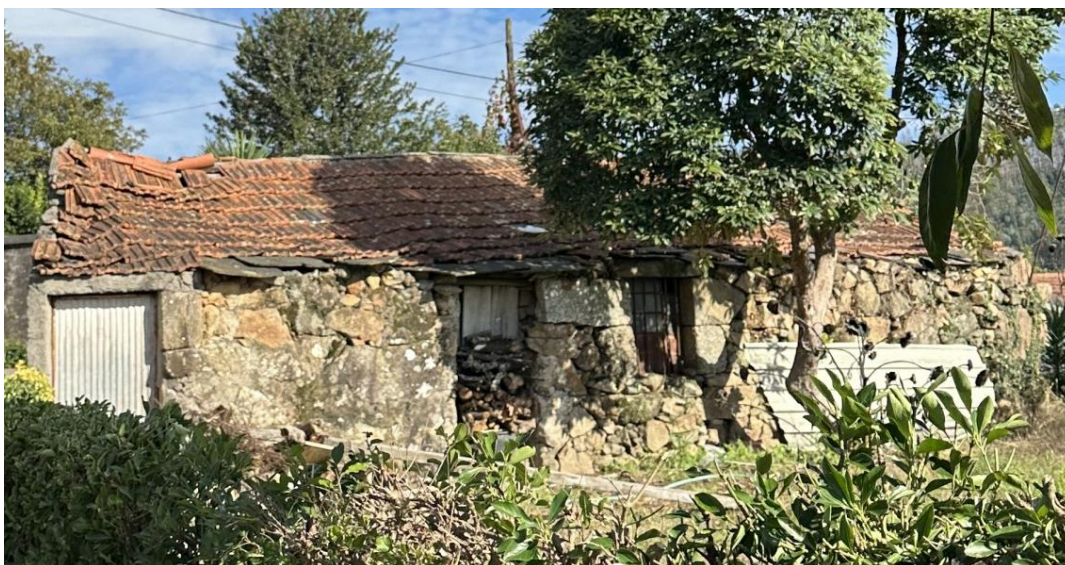
Figura 25. Coberturas colapsadas
