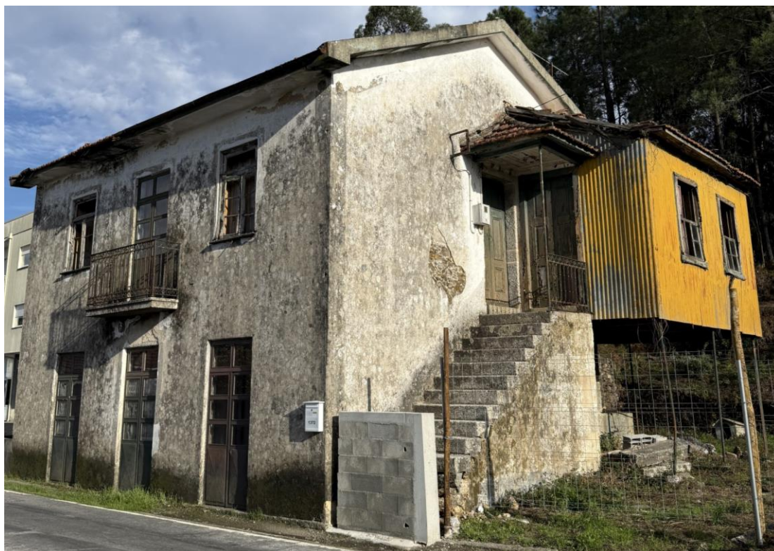
Figura 30. Caixilhariias degradadas
