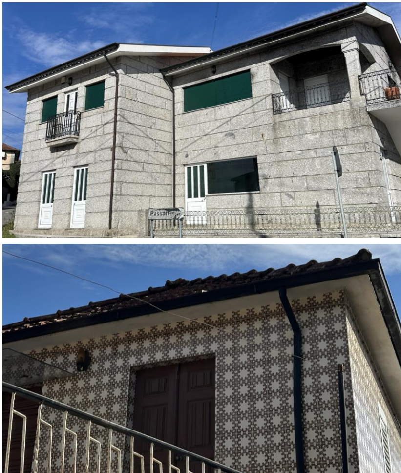
Figura 23. Cobertura com caleira
