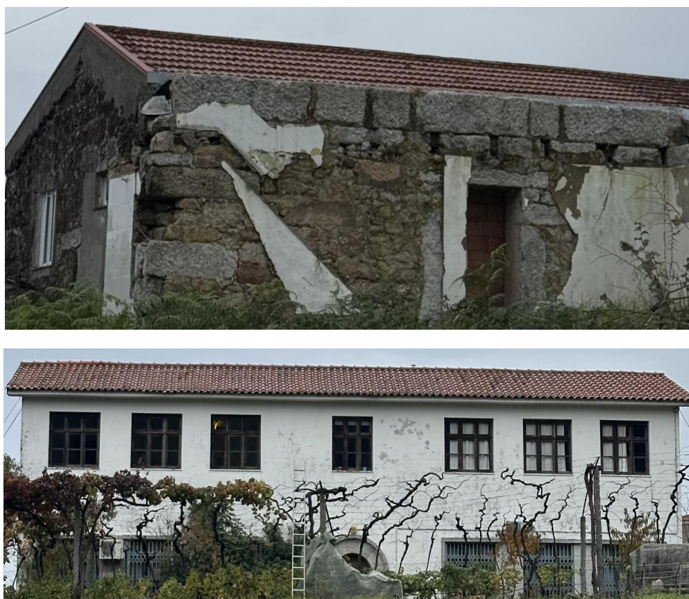
Figura 29. Desagregação do reboco
