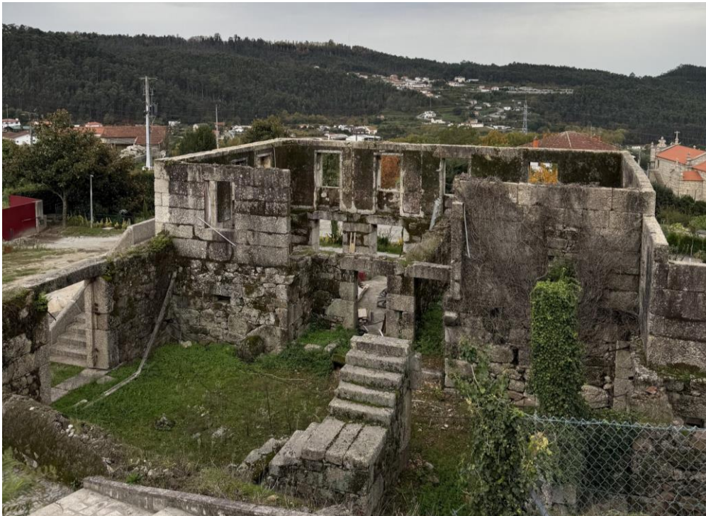
Figura 26. Coberturas colapsadas
