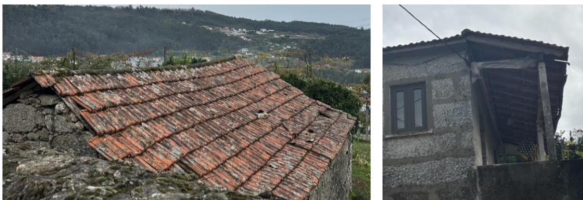
Figura 25. Coberturas deformadas
