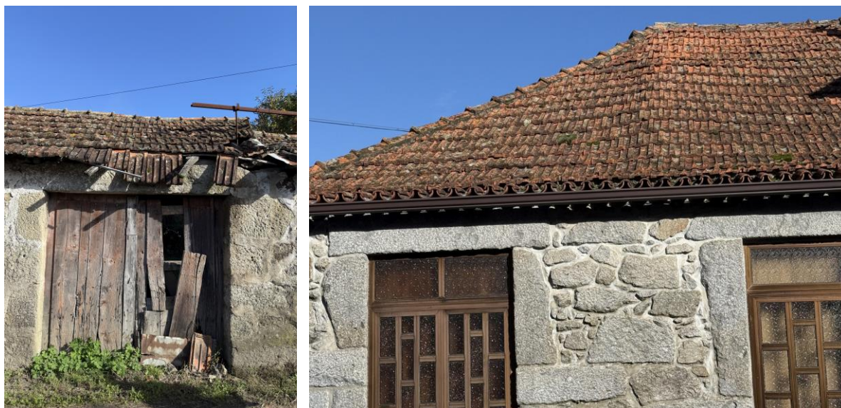
Figura 24. Coberturas deformadas
