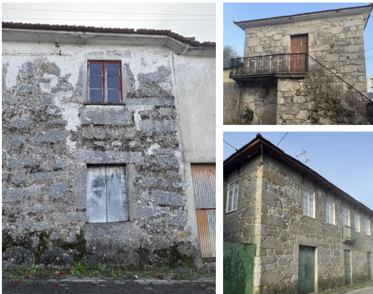
Figura 30. Caixilharias degradadas
