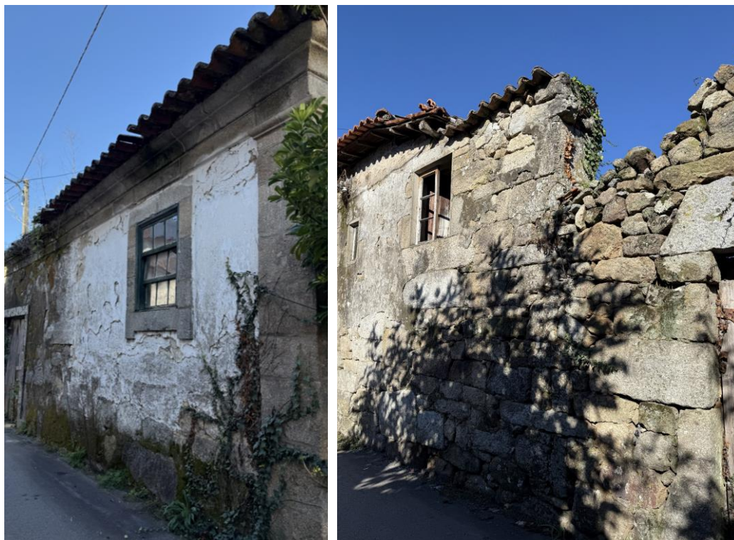
Figura 25. Coberturas colapsadas
