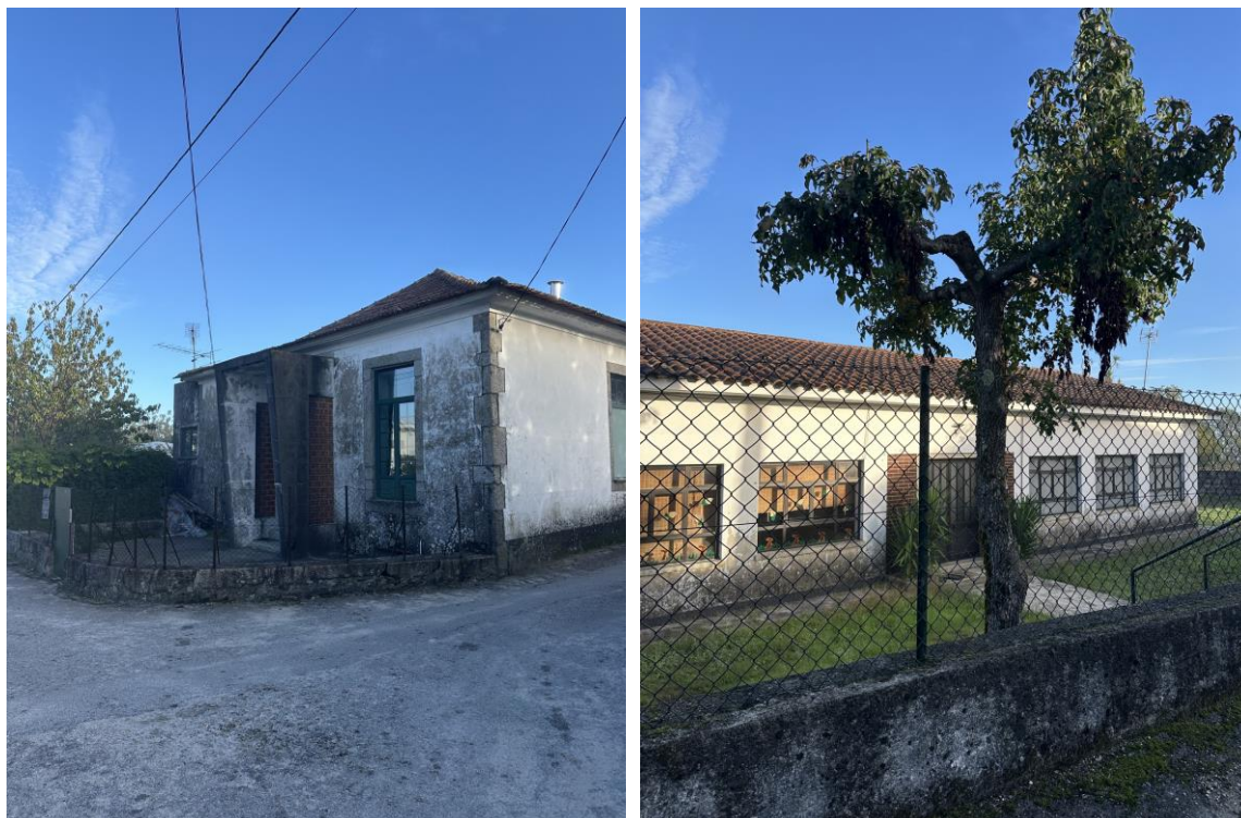
Figura 41. Edifícios da antiga escola
