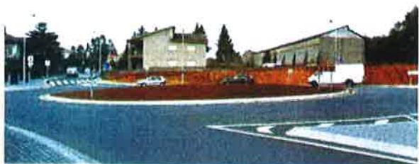
Rotunda de Interseção entre a Av. da República e a EN101
