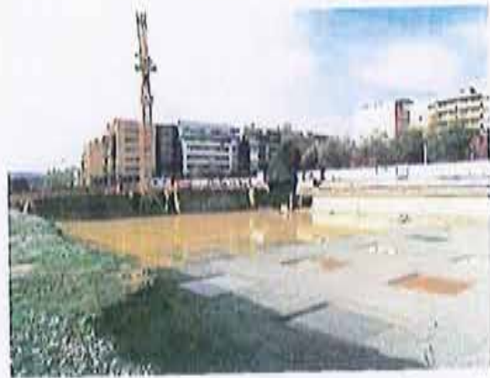
Na cidade da Lixa, iniciaram as obras na Praça do Comércio - Animação/lazer - que contemplam a construção de um bar, parque infantil, palco, sanitários, circuito de manutenção e half-Pipe.
