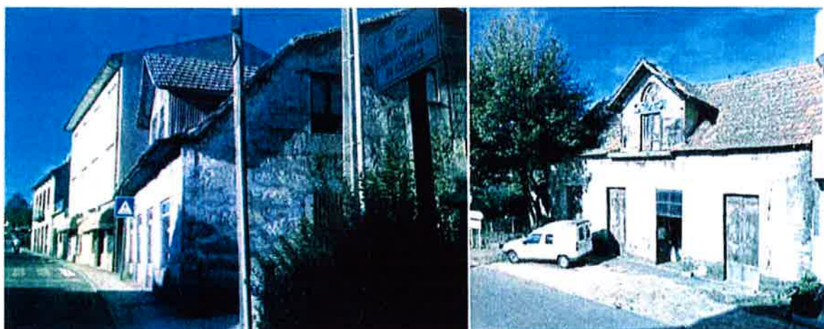
Figura 14. Edifício em mau estado de conservação.
