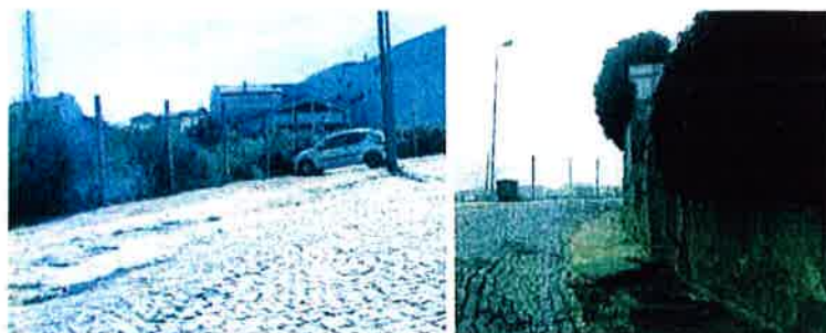
Figura 27. Inexistência de infraestruturas pedonais/ Rua Padre Custódio Marinho
