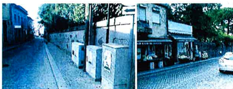
Figura 28. Infraestruturas pedonais obstruídas/ Rua Dr. Leonardo Coimbra e EN101.
