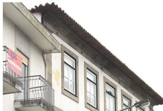
83 | Telhado com beirado e sem recolha de águas pluviais
