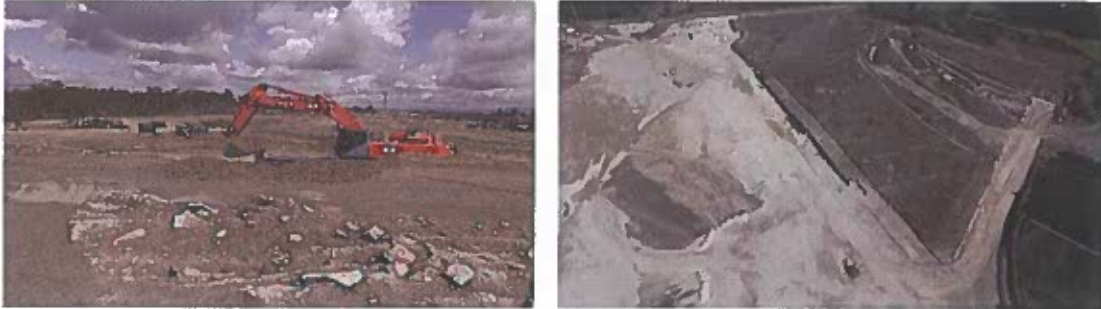
Figura 6 – Aspeto das obras de urbanização em curso
